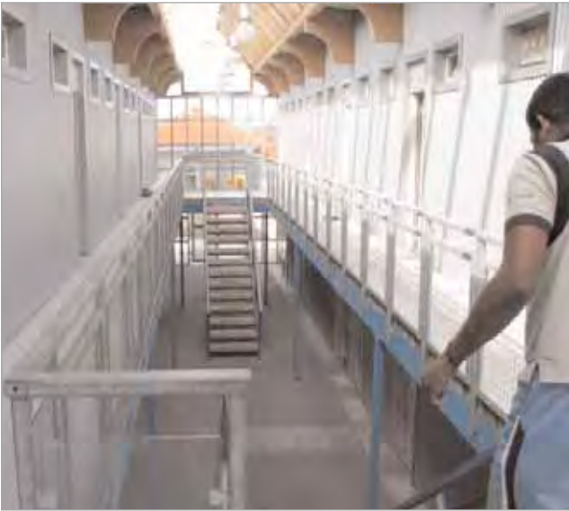
GU Blaufelden (Lkr. Schwäbisch Hall): Neubau aus dem Jahr 2002 mit offenen Außenseiten, durch die im Winter der kalte Wind pfeift
